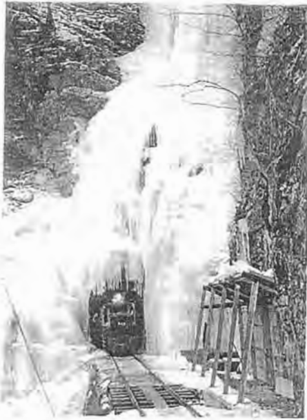
厳寒のメカネ隧道
