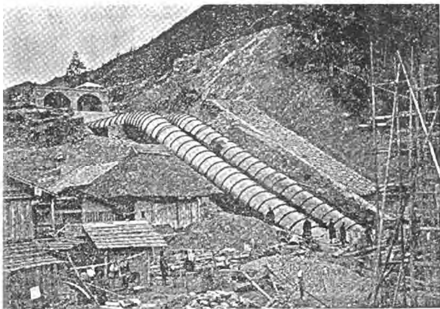
地名発電所建設工事(明治42年)
