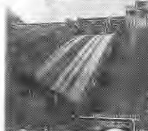
↑下流より井川ダムを見上げる 発電機機
