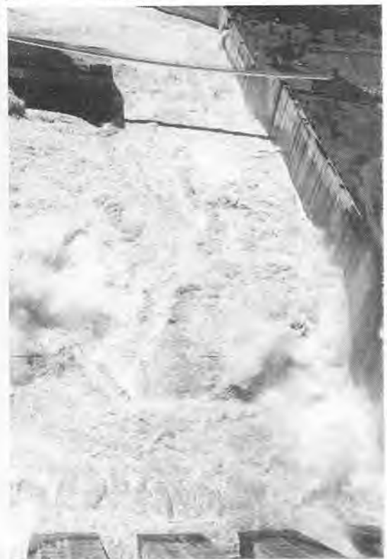
ダム天端から放水の様子をのぞく。左端、右端から放水。約80mの内に6門の洪水吐があり、最大放水量は1門約1000t/s。つまり、毎秒、6,000tの放水能力をそなえているとの事。今回の長島ダムにおける洪水吐放水量は2門合わせて1500t/s。もし、2000t/sの放水をしたら、千頭駅付近、本川根中学校・徳山地区、などは完全に水没していたであろう。恐い光景を写し、早々に立ち去った。
