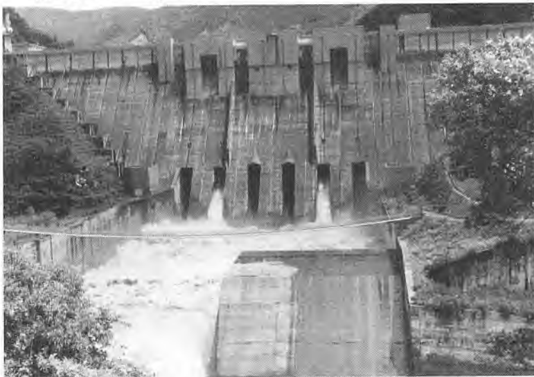
13時頃の長島ダム。6門の洪水吐の内、2門が作動中。初めて見る放水は圧巻そのもの。
