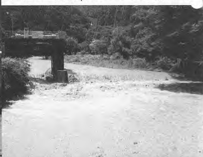
↑ 元藤川の榛原川河口の様子。↑ 旧橋より上流 ← 中部電力取水路取水口。上流に大崩壊地があり土砂と泥水の排出が大きい。← は新橋より大井川への注ぎ口を望む。土砂と共に流木もある。
