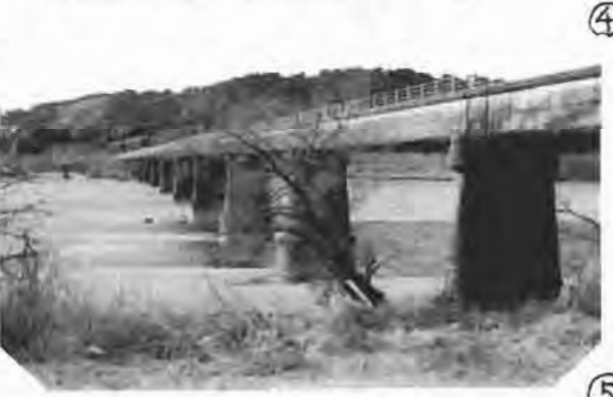
写真④ 大井川用水の小笠平幹線・神座―五和間の水路橋。戦後間もない建設の為に老朽化と、いちじるしい河床の低下の為、50m位下流に新しい水路橋の架替工事が進められている。
