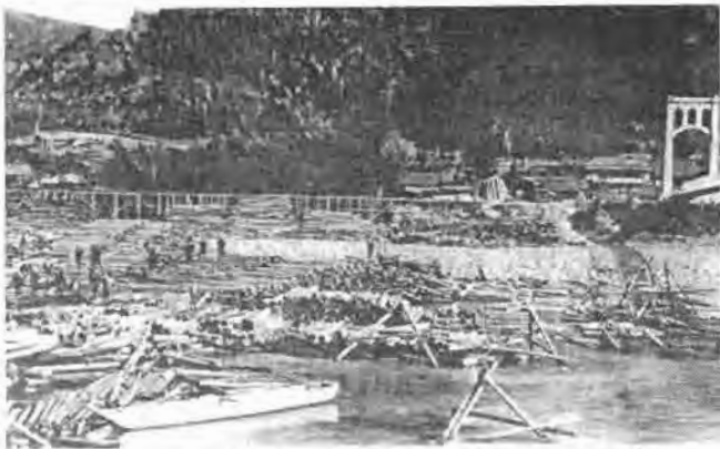
↑大井川ダムが出来る前の本川松町千頭前の大井川流送の集積場。(この下流へ筏で流送されていた)お舟の堰井。
