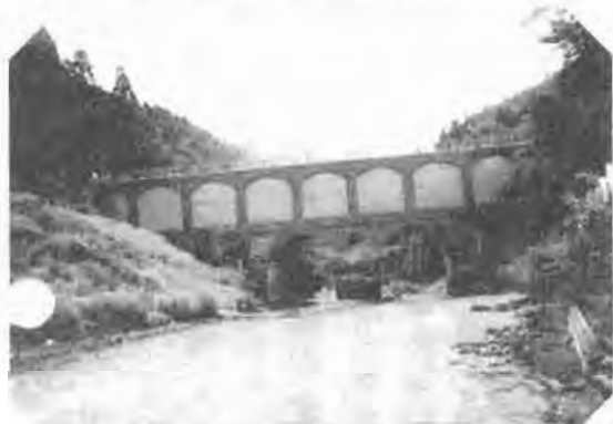
長尾川水路橋、60年前に建設された当時のまの姿で、毎秒数十トン水を流している。
