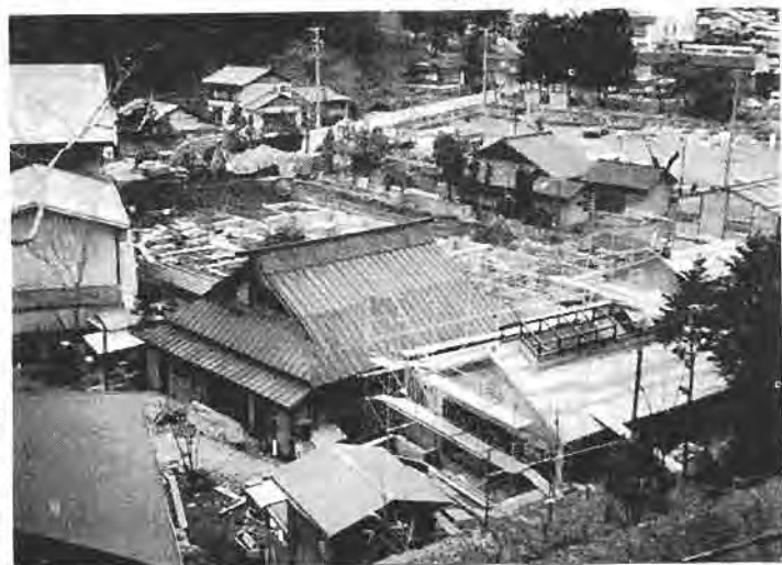
基礎・捨コン打設。手前のあかね亭 静岡市大川八草の旧敷を望月恒一さんが買って移築したものです。
