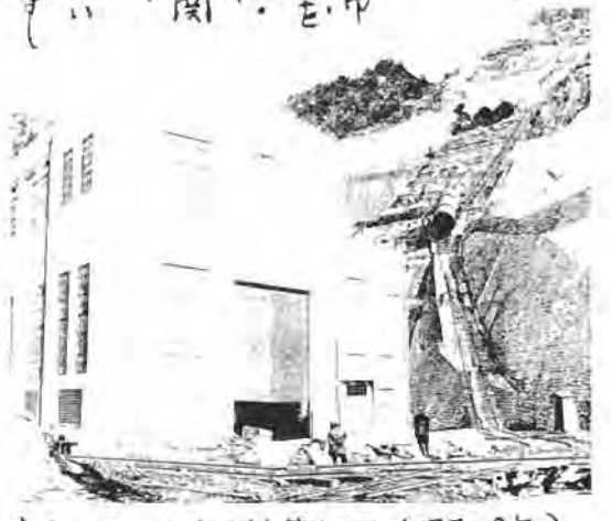
工事中の大川川発見所第1工区(昭和9年)
