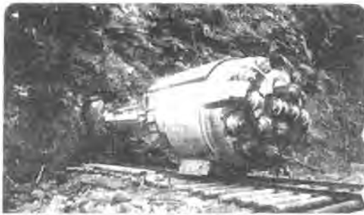
TBMトンスルボーリングマシンによる石沢発電所
