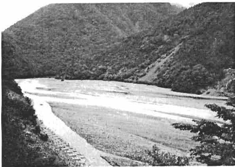
畑 薙 第一ダム上流の大井川の堆積土砂
