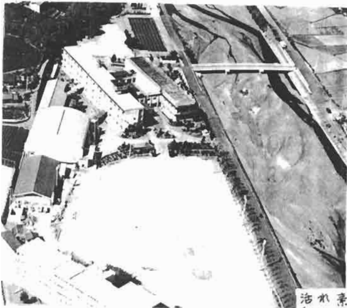
旧校舎及中、中、学校施設全景
